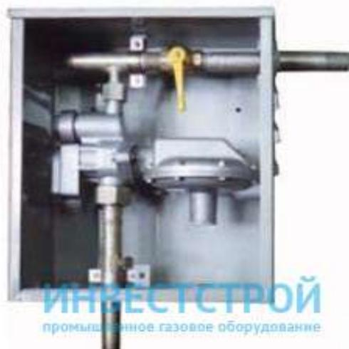
**ГРПШ-10 (10МС)** — газорегуляторный пункт шкафной коммунально-бытового назначения используются для стабилизации среднего или высокого давления природного газа на низкое и автоматического поддержания его с заданной точностью независимо от изменений входного давления и расхода, а также автоматического отключения подачи газа при аварийном повышении или понижении выходного давления сверх допустимых заданных значений.
