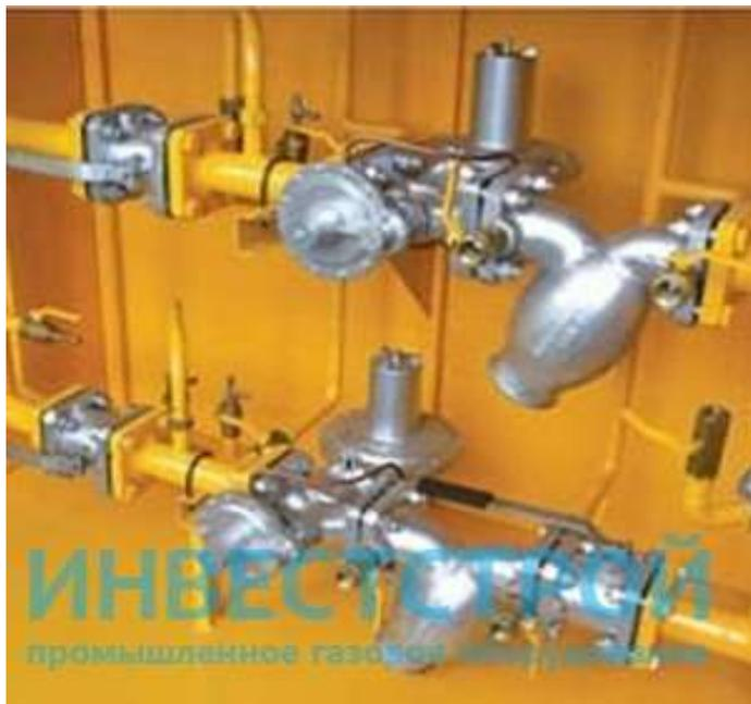
Шкафные газорегуляторные пункты ГРПШ предназначены для редуцирования высокого или среднего давления на требуемое, автоматического поддержания заданного выходного давления, и автоматического отключения подачи газа при аварийном повышении или понижении выходного давления от допустимых заданных значений, очистки газа, поставляемого потребителю по ГОСТ 5542–87.
