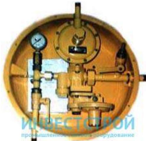
ГРПШК-10 — газорегуляторные пункты шкафные применяемые для снижения среднего или высокого давления газа на низкое и стабилизации его на необходимом уровне в системе газоснабжения жилых и промышленных объектов.
