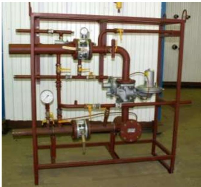
**ГРУ (газорегуляторная установка)** — это комплекс технологического оборудования и устройств для редуцирования высокого или среднего давления на низкое, автоматического поддержания выходного давления на заданном уровне, независимо от изменения входного давления и расхода, автоматического прекращения подачи газа при повышении или понижении выходного давления сверх заданных значений, а также очистки газа от механических примесей.
